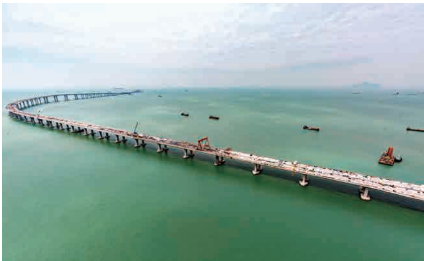
圖 367 大澳對開的港珠澳大橋海上高架橋，攝於 2017 年 4 月 13 日。(政府新聞處提供)
