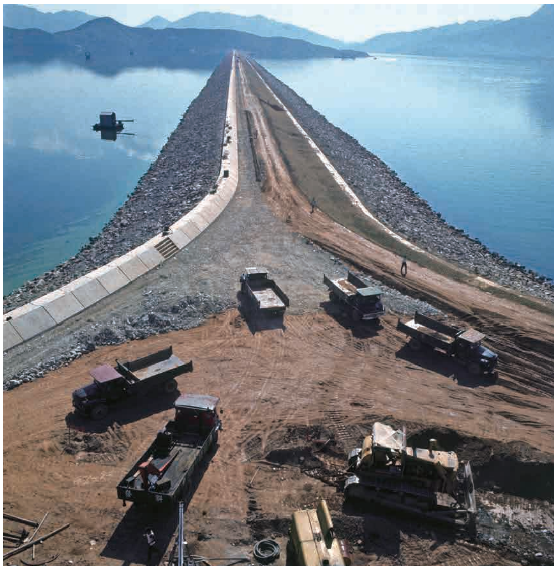
圖 186 興建中的船灣淡水湖，是全球首個以海中築壩方式興建的水塘，堤壩長約兩公里，攝於 1968 年。（政府新聞處提供）
