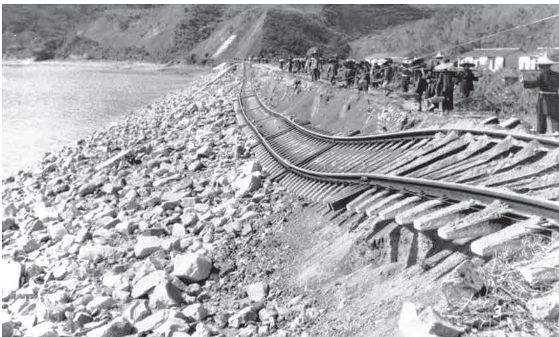
圖 116 1937年，九廣鐵路沙田一段被颱風吹毀的情形。（政府檔案處提供）
