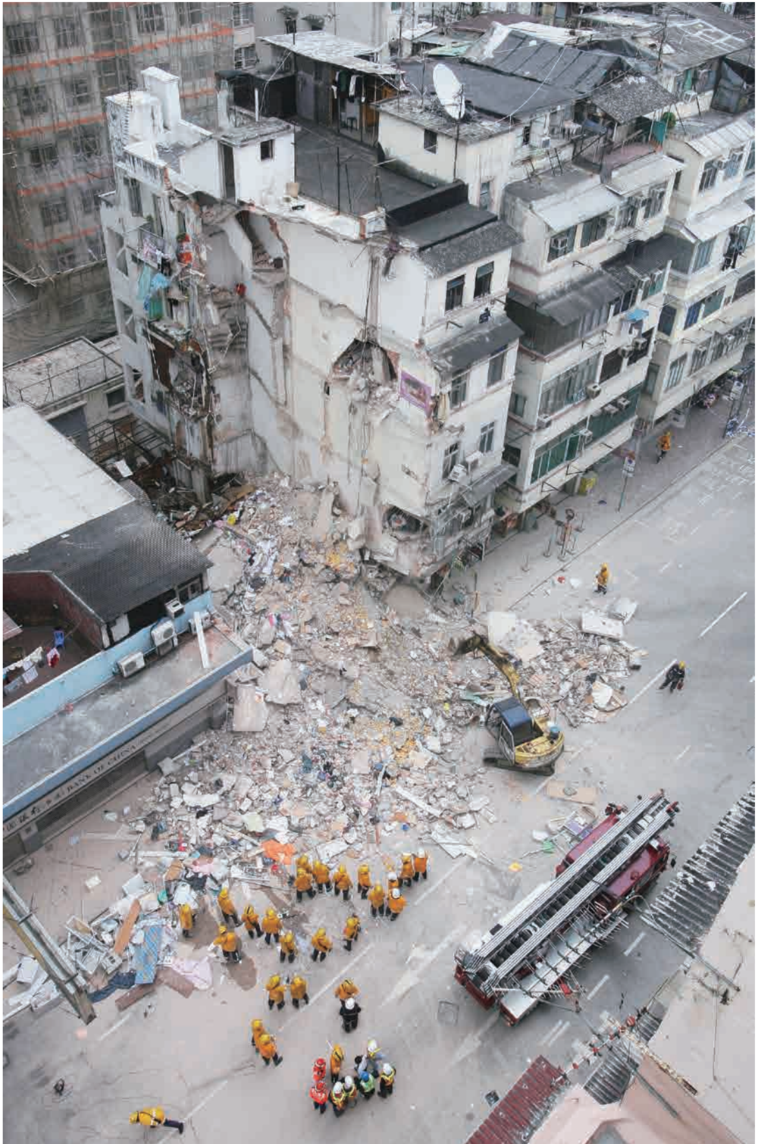
圖 340 2010 年 1 月 29 日，土瓜灣馬頭圍道 45 號唐樓倒塌現場，消防員全力拯救被困傷者。（南華早報提供）
