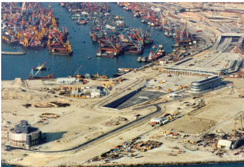
圖 261 西九填海區的西區海底隧道入口，攝於 1997 年。(政府新聞處提供)
