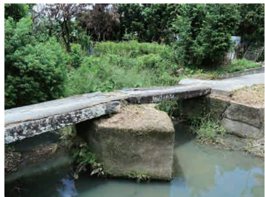
圖 026 錦田水頭村便母橋現貌，攝於 2020 年。(香港地方志中心拍攝)
