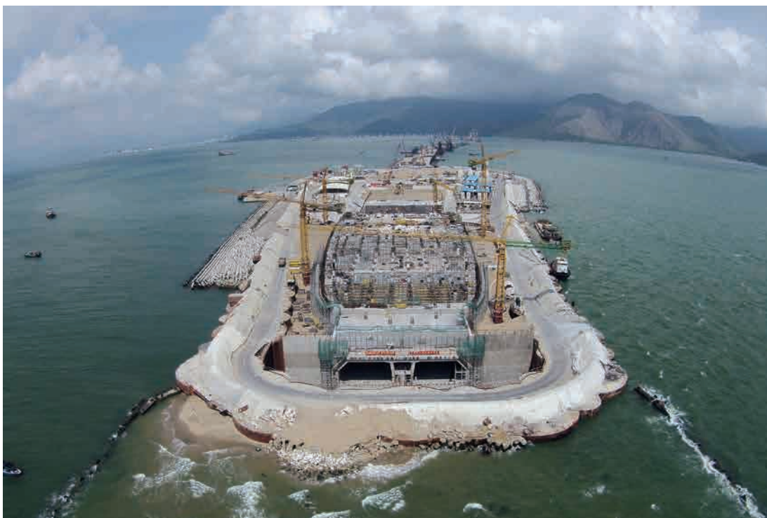
圖 368 正在興建中的港珠澳大橋東人工島全景，攝於 2015 年 6 月。(錢仕程拍攝，港珠澳大橋管理局提供)
