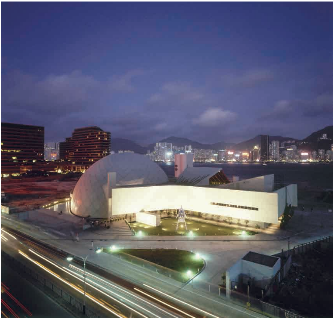
圖 221 尖沙咀海旁的香港太空館，其半圓形建築成為香港地標，攝於1982年。(政府新聞處提供)
