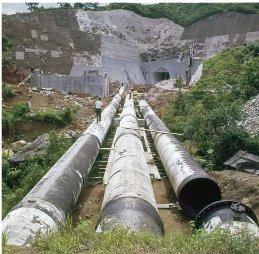
圖175 裝設於新獅子山隧道口、用於輸送東江水至船灣淡水湖的密封輸水管，攝於1964年。（政府新聞處提供）
